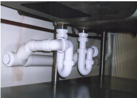
Şekil-4.3: Borulu ve şişe tipli sifonlar
